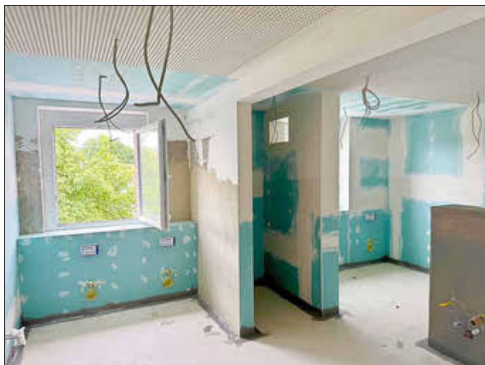
Baustelle im Kindergarten „Kleine Rasselbände“
