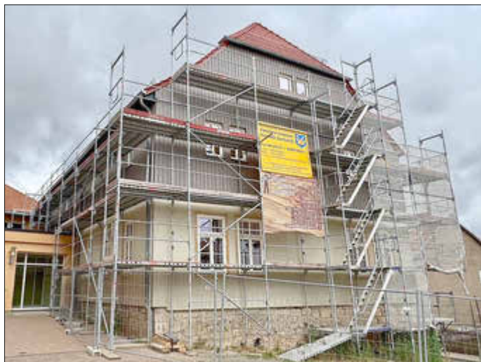
In Kürze wird bei der Gemeindeschenke in Wölfis hoffentlich das Gerüst fallen!
