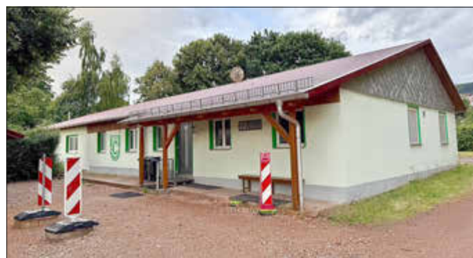
Kegelbahn Crawinkel – im Inneren fertig, nur außen gibt's noch etwas zu tun.
