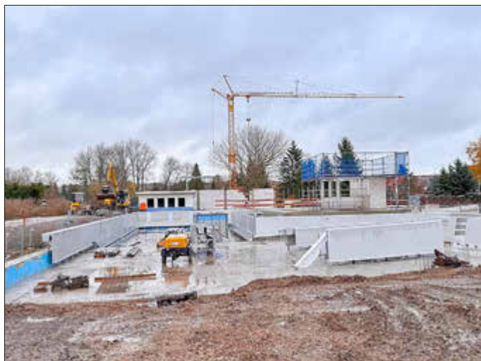
Blick auf die Schwimmbadbaustelle im Spätherbst 2025.
