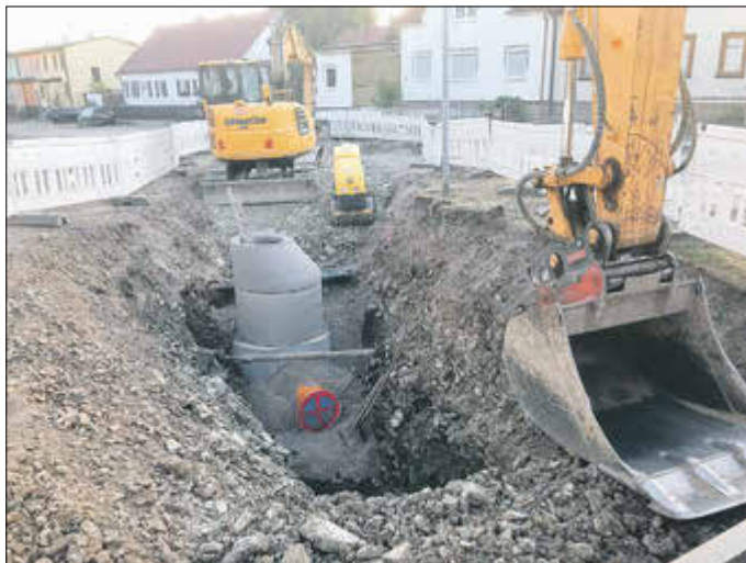
Vortrieb des Abwasserkanals in der Brunkelstraße
