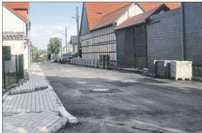
Blick in die zu Ende gehende Baustelle in der Gosseler Straße
