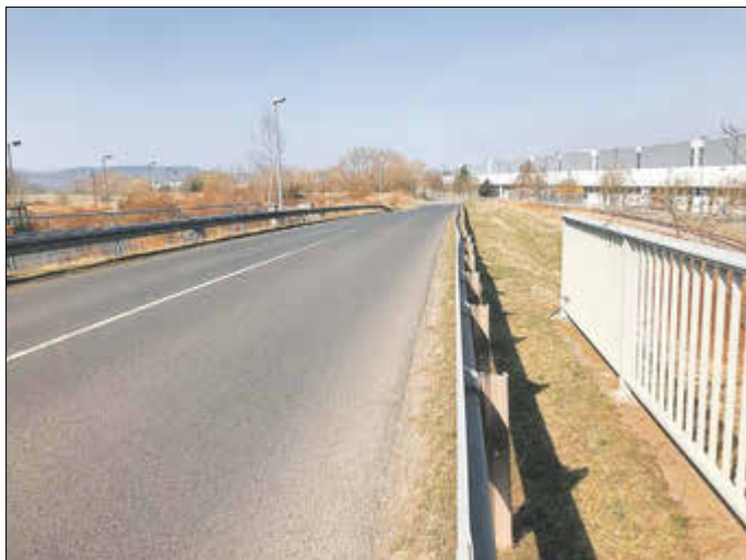
Zukünftige Großbaustelle - Herrenhöfer Landstraße
