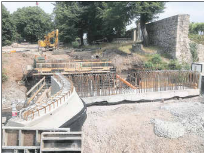
Erneuerung der Ohra-Brücke und von Ufermauerbereichen am Schlosspark.
