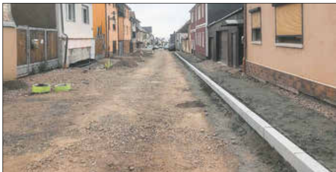
Großbaustelle Steigerstraße – Licht am Horizont!
