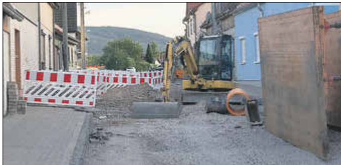
Hermann-Kirchner-Straße - Die Abwasser-Hausanschlüsse werden verlegt.
