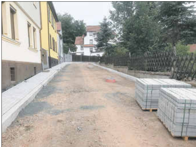
Die Teichstraße wartet schon auf den Bitumen.
