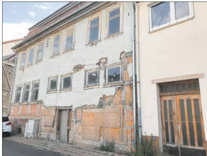
Das gesicherte denkmalgeschützte Gebäude Löberstraße 14.
