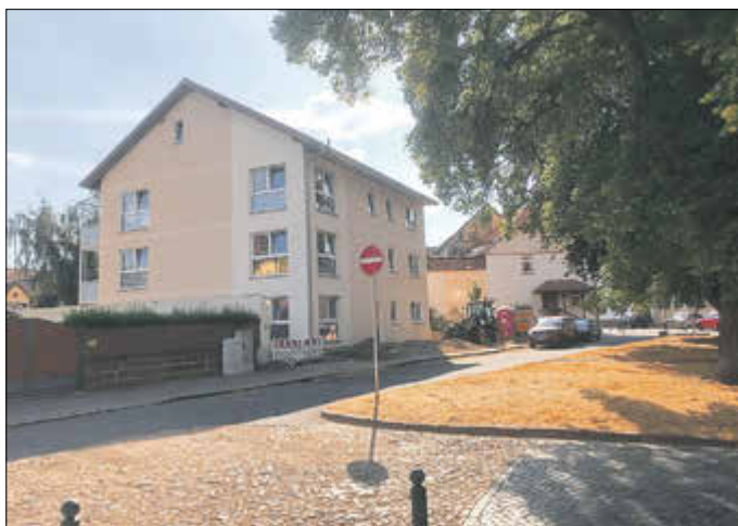
Auf dem Grundstück Michaelisplatz 1 – gelungene Investorenlösung zur Schließung einer störenden Baulücke.
