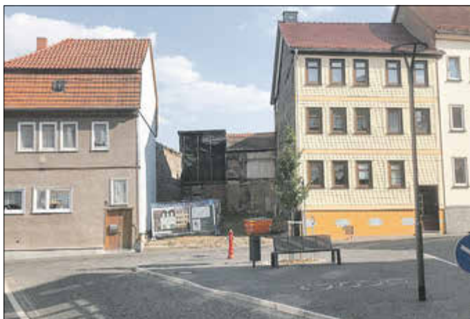
Blick auf die Baulücke in der Goethestraße 19.
