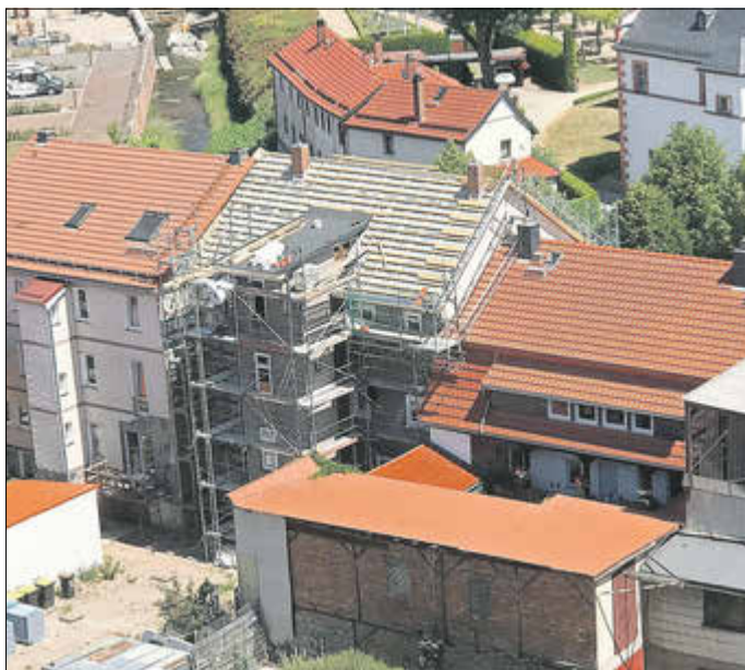
Aufwändige Sanierungsarbeiten am städtischen Wohngebäude Löhnerstraße 6 sind im Gange.
