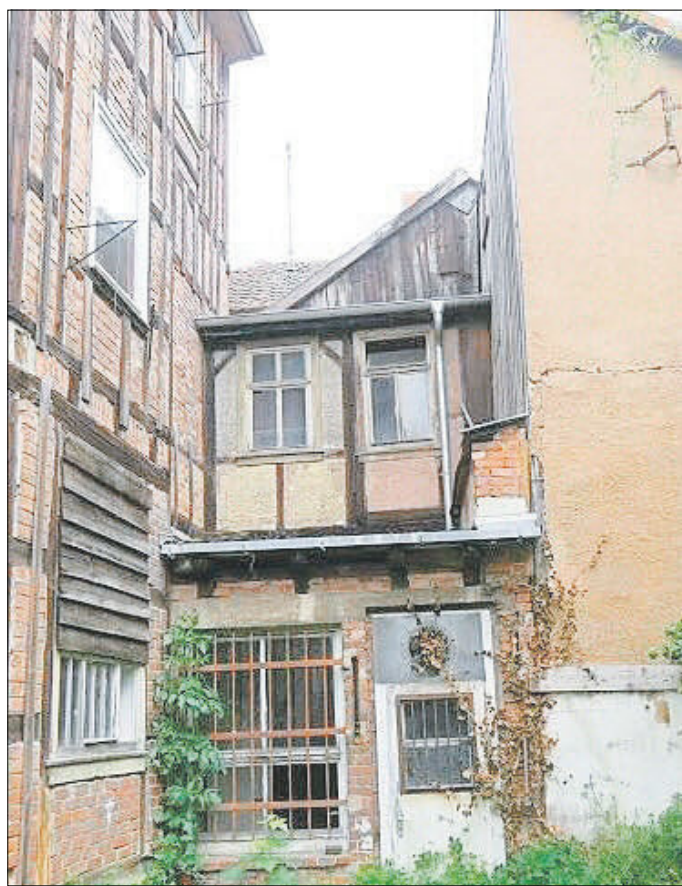
Rückseite des Gebäudes Goethestraße 11
