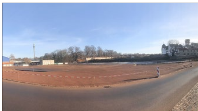
Im Bau befindlicher Park- und Caravanstellplatz
