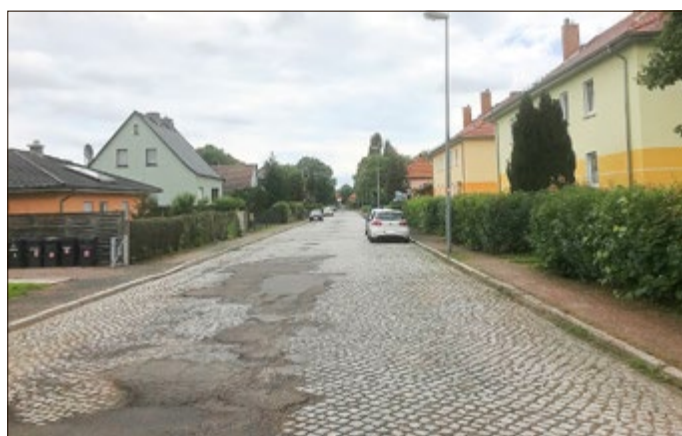
Strengestraße - grundlegender Ausbau beginnt 2021
