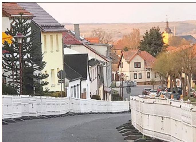
Großbaustelle Steigerstraße Gräfenhain
