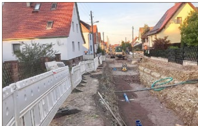
Grundhafter Ausbau der „Zum Vetterberg“ wird fortgesetzt.
