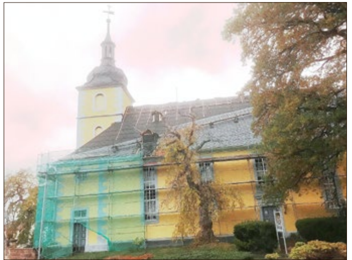
Dacherneuerung der Dreifaltigkeitskirche in Gräfenhain, einer der schönsten Dorfkirchen in Thüringen
