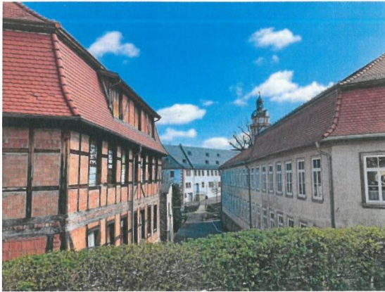
Blick zur Michaelisschule, Schloss Ehrenstein und Michaelisplatz 4. Das Gebäude (links) ist zur weiteren Sanierung gesichert worden. Foto: Wieland Fischer
