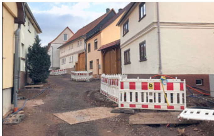
Baustelle Käfergasse Wölfis
