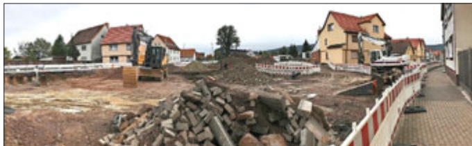
Großbaustelle B 88-Kreuzung in Crawlinkel
