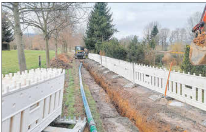
Verlegung von Rohrleitung an den Gärten hinter dem Markbrunnen
