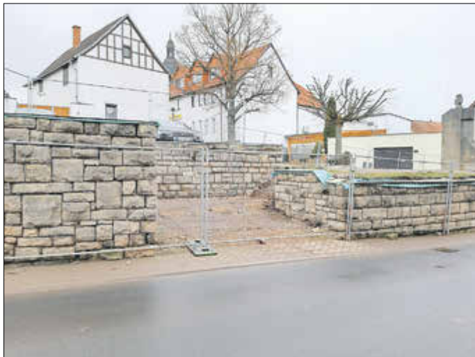
Baustelle Treppenaufgang neben dem Kriegerdenkmal
