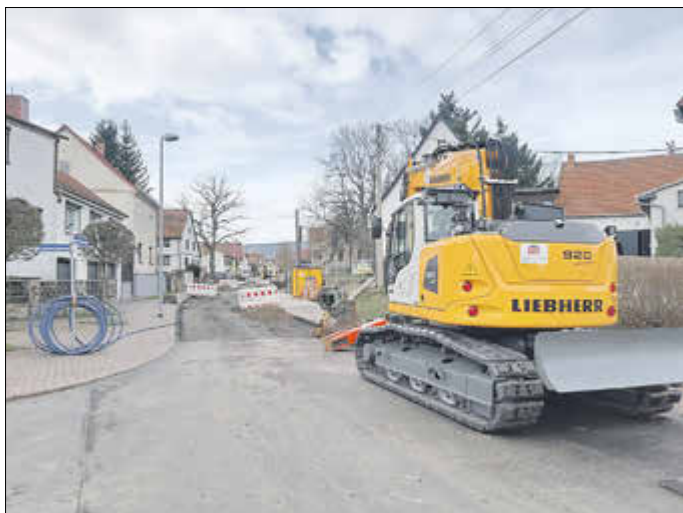
Bauarbeiten in der Hermann-Kirchner-Straße
