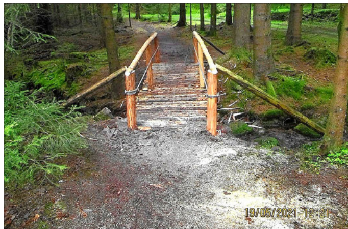
Fertigstellung der Brücke
