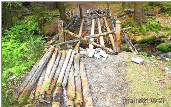
Bauarbeiten an der Brücke
