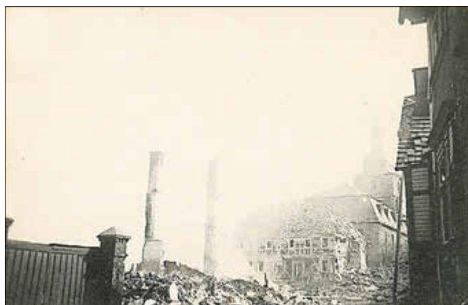
April 1945 – Zerstörte Gebäude in der Kirchgasse
