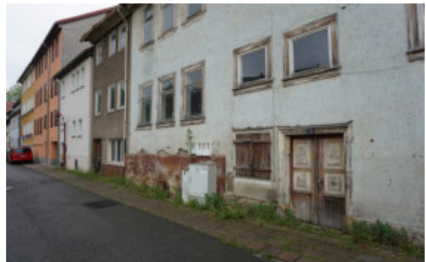
Abb. 34: Gebäudesicherung Löberstraße 14 in der Kernstadt Ohrdruf Quelle: DSK 2019
