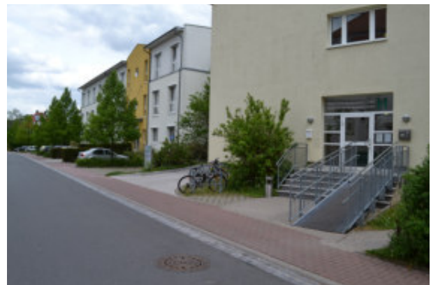
Abb. 173: Helios Residenz Ohrdruf, Rötterstraße Quelle: DSK 2016
