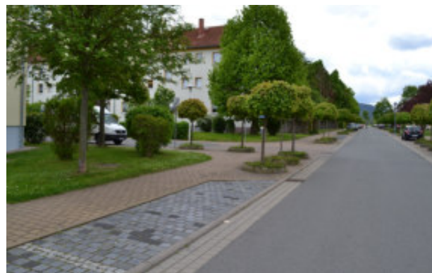
Abb. 109: Sanierter Straßenraum Clara-Zetkin-Straße Quelle: DSK 2016
