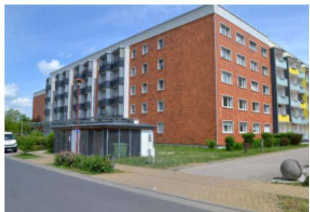
Abb. 22: Sanierter Wohnblock „Leichfeld“ (industrielle Plattenbauweise) Quelle: DSK 2016
