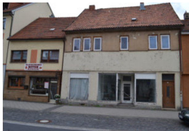
Abb. 26: Struktureller Leerstand Wohn- und Geschäftshäuser Waldstraße Quelle: DSK 2016
