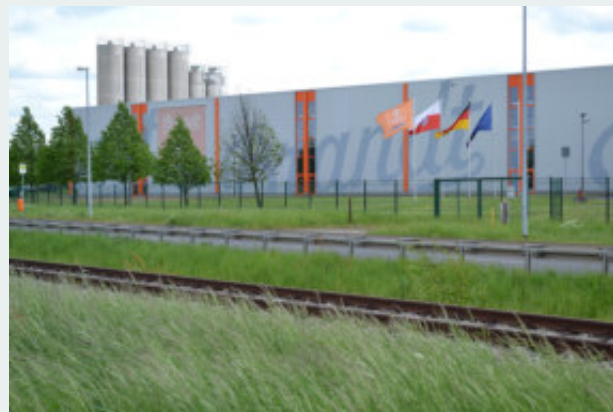
Abb. 123: Firmengelände Brandt Quelle: DSK 2016
