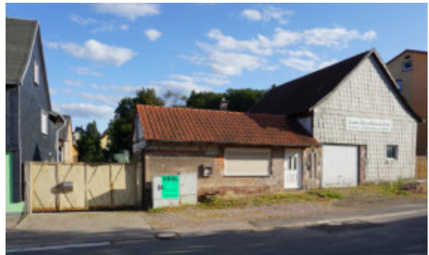
Abb. 130: Leerstand eines ehemaligen Betriebs im Ortsteil Gräfenhain Quelle: DSK 2019
