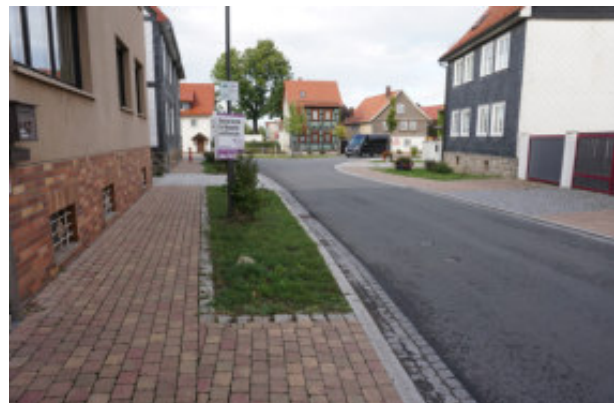
Abb. 38: Sanierter Straßenraum Bachstraße in Crawinkel Quelle: DSK 2019
