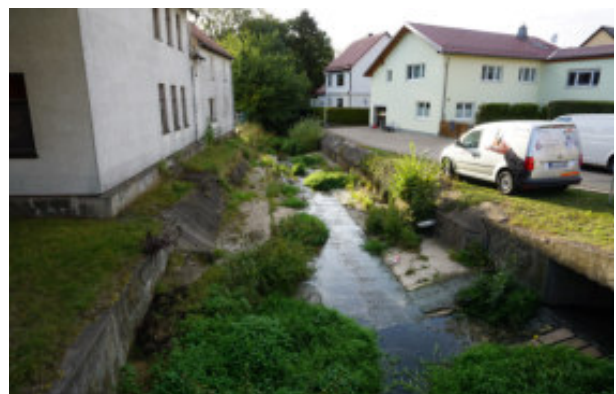
Abb. 63: Sanierungsbedürftiger Bachlauf Quelle: DSK 2019
