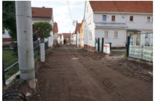
Abb. 46: Laufende Sanierungsmaßnahmen Hintergasse Quelle: DSK 2019
