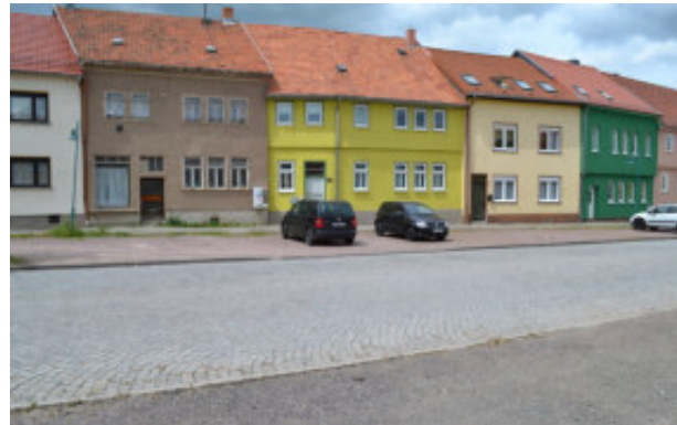
Abb. 108: Rückblick: Unsaniertem Straßenraum Waldstraße 2016 (2019 saniert) Quelle: DSK 2016
