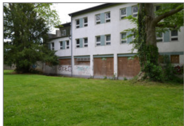
Hotelbrache im südlichen Bereich des Stadtparks Quelle: DSK 2016
