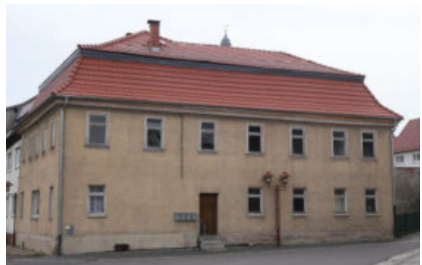
Abb. 35: Gebäudesicherung Löberstraße 18 in der Kernstadt Ohrdruf Quelle: DSK 2019
