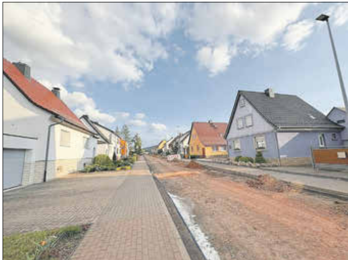
Baustelle in der Kienbergstraße in Wölfig
