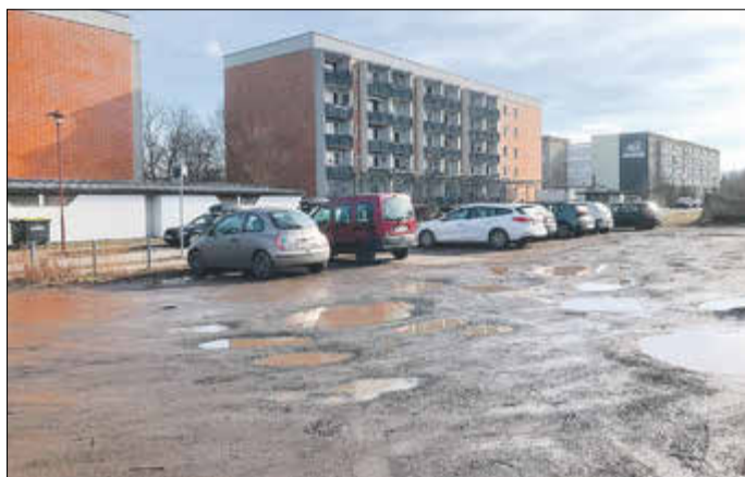
Blick auf einen Teil der Privatfläche, der durch Tausch städtisches Eigentum geworden ist und nun zum befestigten Parkplatz werden soll.
