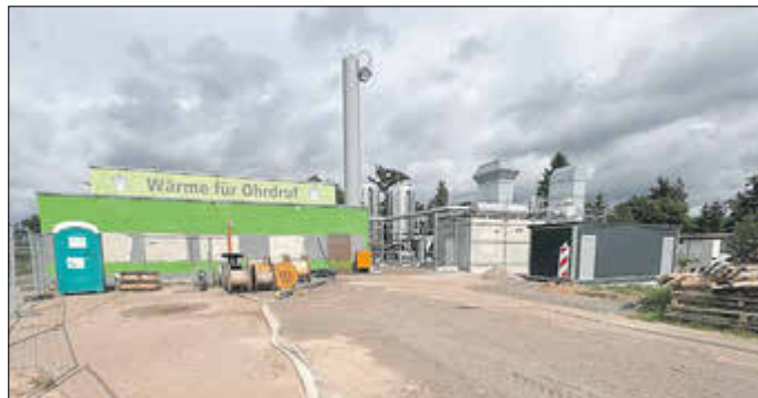
Blick auf die neuen technischen Anlagen des Ohrdruffer Heizhauses
