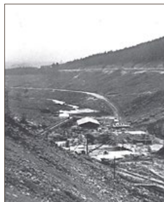
Baustelleneinrichtung an der Sohle zur Talsperre
