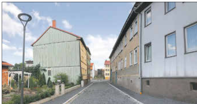
Die erneuerte Straße Bonifatiusplatz
