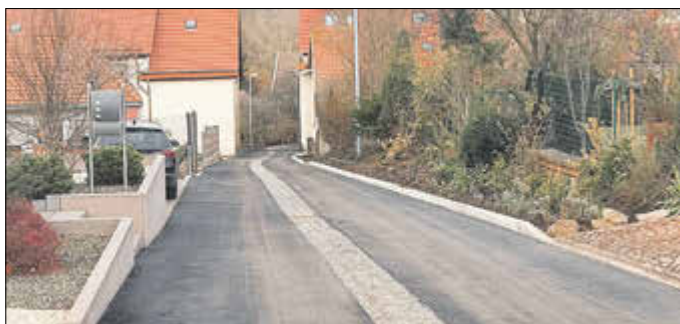
Neuer Abschnitt der Teichgasse
