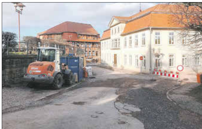
Baumaßnahme rund um die Michaelisschule
