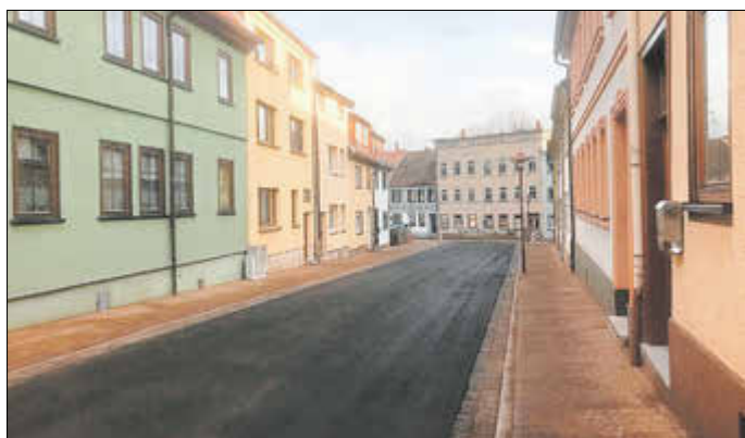
Blick in die 2018 erneuerte Vollrathstraße
