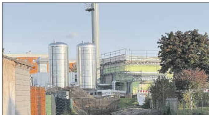
Heizhaus und Heiztrasse aus Richtung Scherershüttenstraße gesehen.
