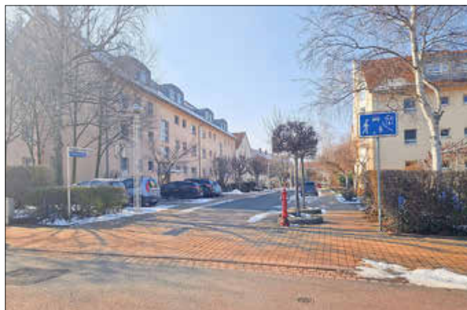
1. Bauabschnitt der Friedrichstraße in Ohrdruf ist abgeschlossen und der 2. Bauabschnitt startet
