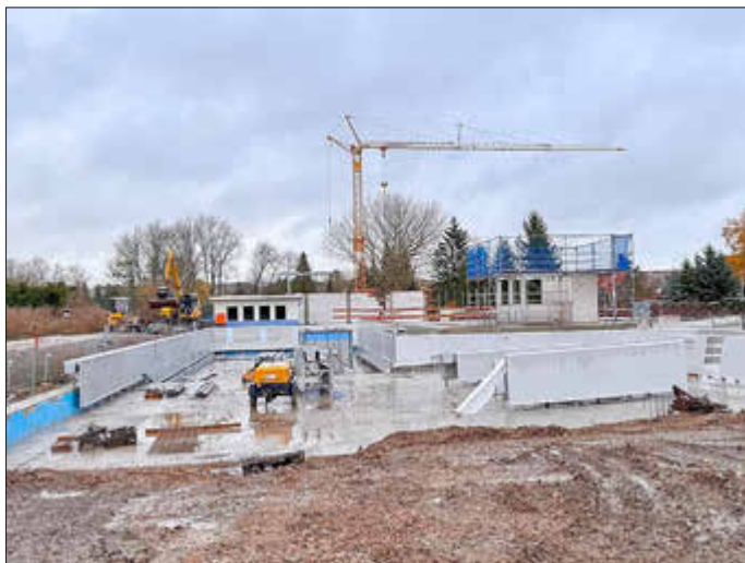
Aktueller Blick über die Schwimmbadbaustelle.
