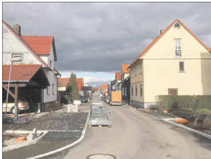
Sichtbarer Baufortschritt in der Kleinen Oststraße
