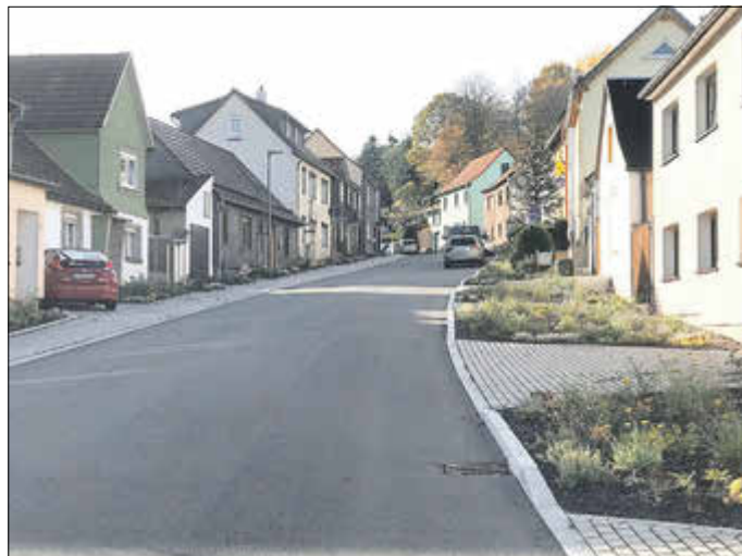
Blick in die sanierte Steigerstraße
