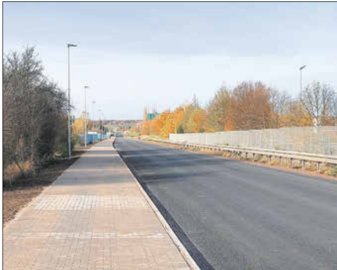
Erneuerung der Herrenhöfer Landstraße
