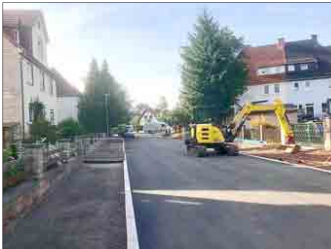
Aktuelle Baumaßnahme im Herrenhöfer Weg in Ohrdruf
