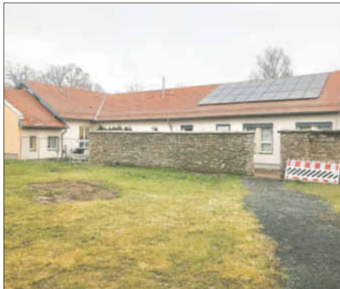
Freier Blick von hinten nach dem Abriss der alten Gebäude.
