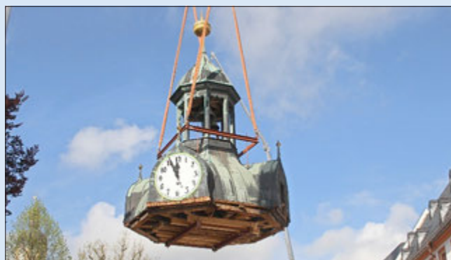
Die Turmhaube vom Schloss Ehrenstein wird für die Sanierung abgenommen
