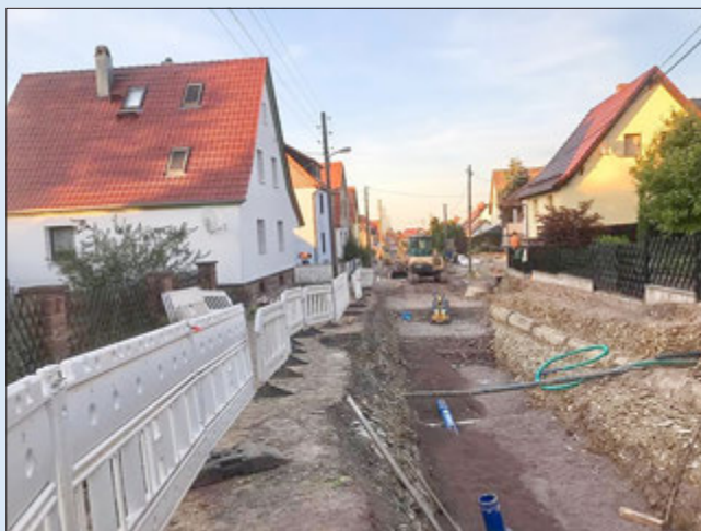
Die Straße „Zum Vetterberg“ in Crawinkel wird grundhaft ausgebaut
