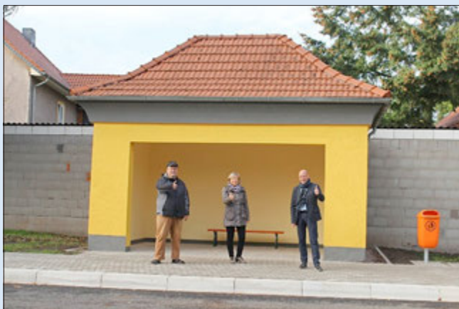
Parallel zur vom Land durchgeführten B88-Sanierung durch Gräfenhain wurden die Bushaltestellen in der Weststraße saniert und barrierefrei ausgebaut.
