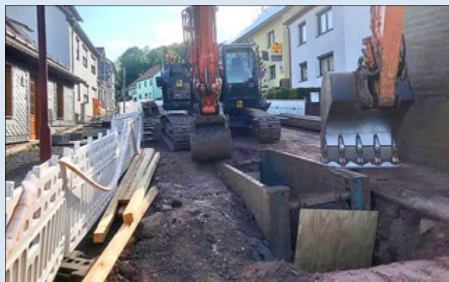
Die Sanierung der Steigerstraße in Gräfenhain startet in diesem Jahr.
