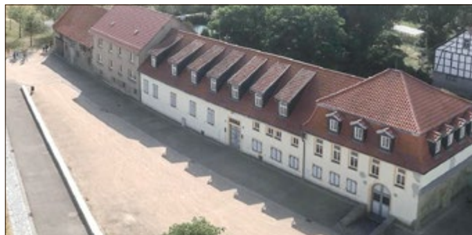
Blick von oben auf die Gebäude des Jugend-, Kultur- und Vereinszentrums „Netzwerk“
