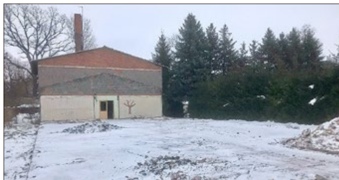
Die Abrissarbeiten hinter der Stadtmauer an der Wölfiger Straße sind in vollem Gange.
