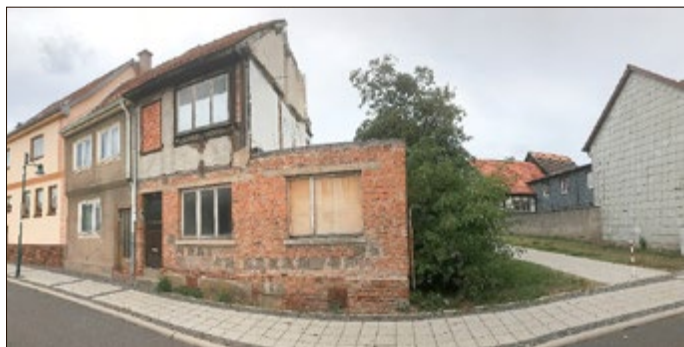
Entstehendes Baugrundstück Waldstraße 93 und 95
