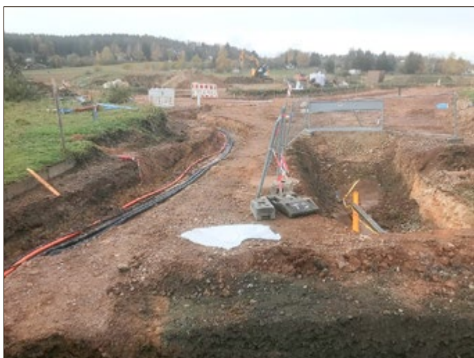
Erschließungsarbeiten „In der Rinn“ in Gräfenhain.
