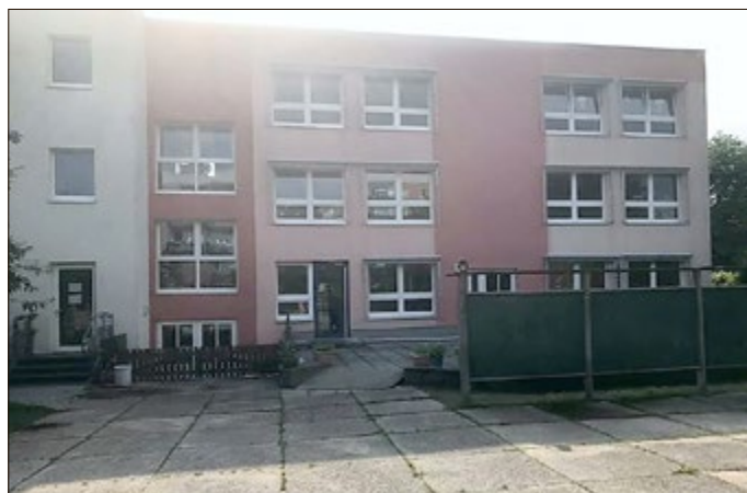
Die „Rasselbande“ von hinten. Hier wird saniert!
