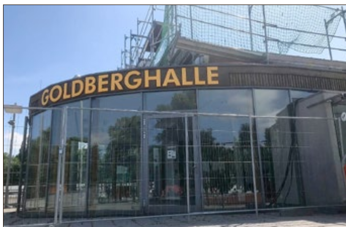
Eingangsbereich der Goldberghalle vor dem Fall der Gerüste.
