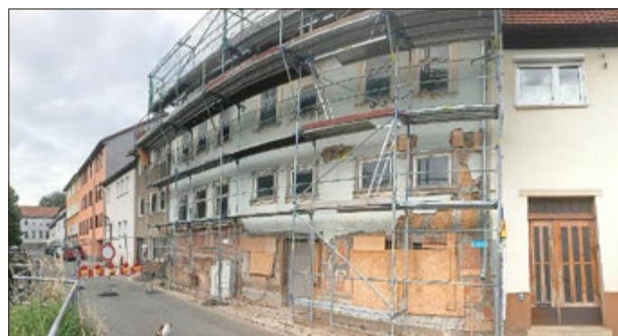
Sicherungsarbeiten am denkmalgeschützten Gebäude Löberstraße 14.
