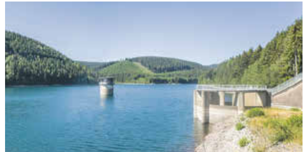
Blick zur Ohratalstausee von der Staumauer. Foto: Stephan van Helden, CC BY-SA 4.0
