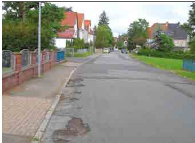
Für den 2019 anstehenden grundhaften Ausbau des Herrenhöfer Weges wurden nach der Ausschreibung im vergangenen Jahr die Baufirmen bereits gebunden.
