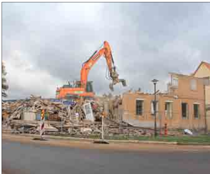
Nach dem erfolgten Abriss des Gasthauses „Zum Lamm“ in Crawinkel soll nun der Kreuzungsbereich neu gestaltet werden.
